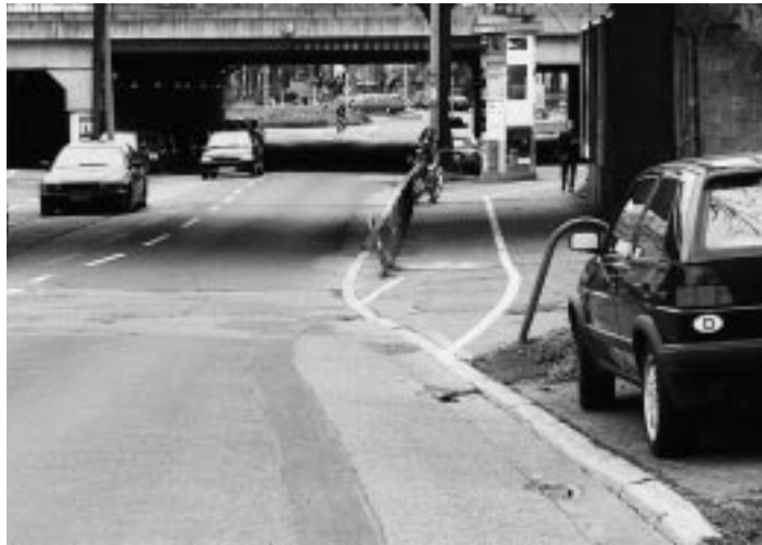
Auch hier noch zu erkennen: Übertünchte Radstreifen vor der Eisenbahnunterführung im Zuge der Oppenheimer Landstraße. Foto: fb
