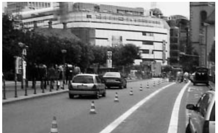
Bild 2: Markierungsarbeiten an der Hauptwache.
