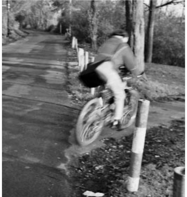
*Flott zwischen den Pfosten hindurch: sichtbare Sperrwerke am Bornheimer Hang hinter der Eisssporthalle. Allerdings wird ein mitten auf dem Weg stehender Pfosten durch den Radfahrer verdeckt. Ebenso ist der Asphaltaufruch in Höhe des Vorderrads hier (wie bei Dunkelheit auch) nicht zu erkennen.*
