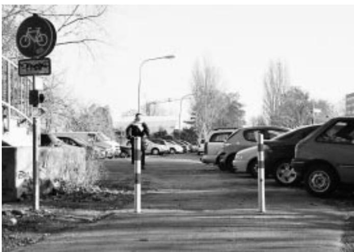
*Schutz vor Missbrauch des Radwegs durch den motorisierten Verkehr: Sperrpfosten, auffällig lackiert, unter der Kaiserlei-Brücke*
