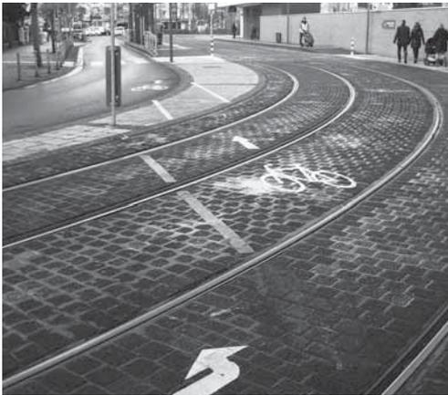
*Sturzgefahr: in der Kurve spitzwinklig die Schienen zu kreuzen, das geht nicht. Wenn schon zwischen den Schienen, dann bitte weiter durch die Haltestelle. Die ruppige Pflasterung kann man mit Bitumen ausgießen.*
