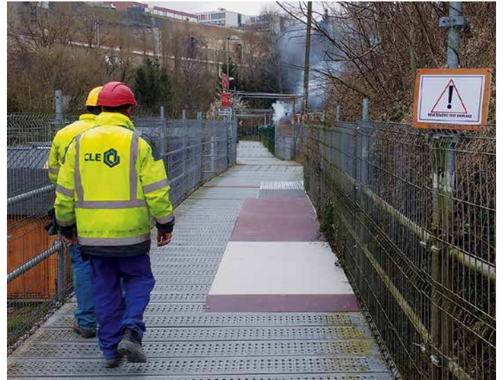
Luxemburg, Alzette-Tal, beliebte Fahrrad- und Wanderstrecke bis direkt unter die City. Für die Großbaustelle der Bahnstrecke musste der Fernradweg als Baustraße herhalten. Die Lösung: nah geführte temporäre Umleitung in Gerüstbauweise.
