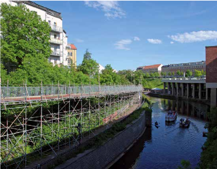
Leipzig, Großbaustelle Karl-Heine-Kanal, 2014. Der Fuß- und Radweg am Kanalufer, beliebte Naherholungsstrecke im Leipziger Westen, war für einen längeren Zeitraum gesperrt. Die Lösung: Gerüstkonstruktion für Fußgänger und Radfahrer.
