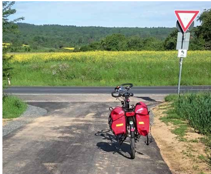
Wir bleiben dran – ganz konkret: Asphaltierter Übergang zwischen Radroute und B519 in Hofheim
