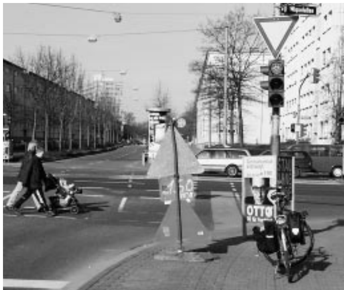
Gemeinschaftsarbeit – wo falsch platzierte Wahlplakate und Baustellenbeschilderung zusammenkommen, wird es eng auf dem Radweg. Foto: (fb)
