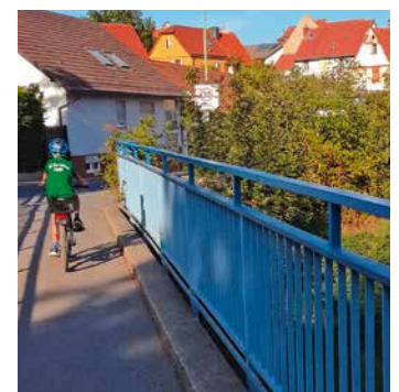
Niddabrücke in Dortelweil: Das erhöhte Gelände schafft mehr Sicherheit
