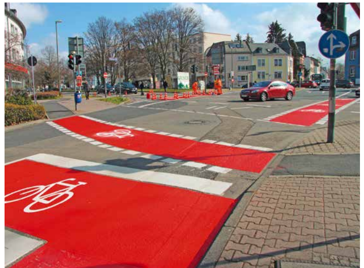
Die Unfall-Kreuzung während der Umgestaltungsarbeiten. Im Vordergrund die vergrößerte, rot markierte Aufstellfläche.
