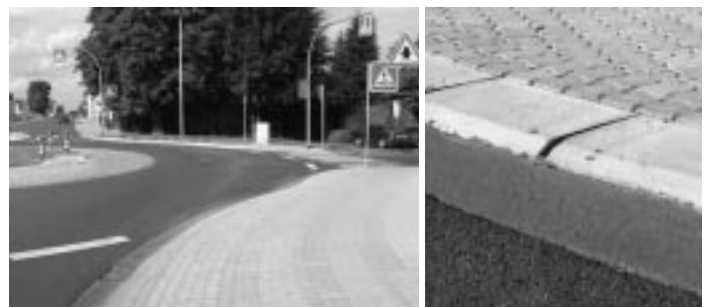
Linienführung des Radwegs im Kreis auf der umgebauten Friedberger Straße und Detail der Bordsteinkante vor gefastem Verbundpflaster
