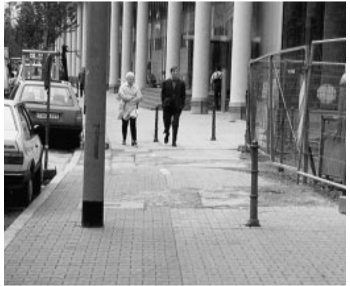
Radweg-Ende an der „Welle“ – Lampenmast mitten auf dem Radweg.
