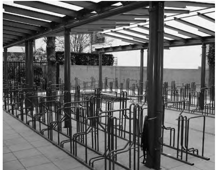
Die in Bau befindliche oberirdische Fahrradabstellanlage
