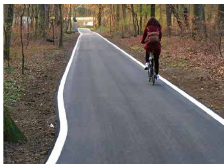
Teilabschnitt der Fahrradachse 6 zwischen Mainradweg und Bieber: Asphaltierung im Eißner-Park
