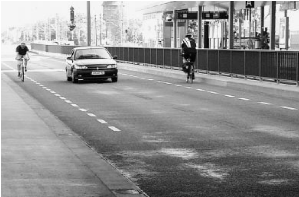
Noch trüben Lücken den positiven Gesamteindruck: Schutzstreifen auf der Emser Brücke.
