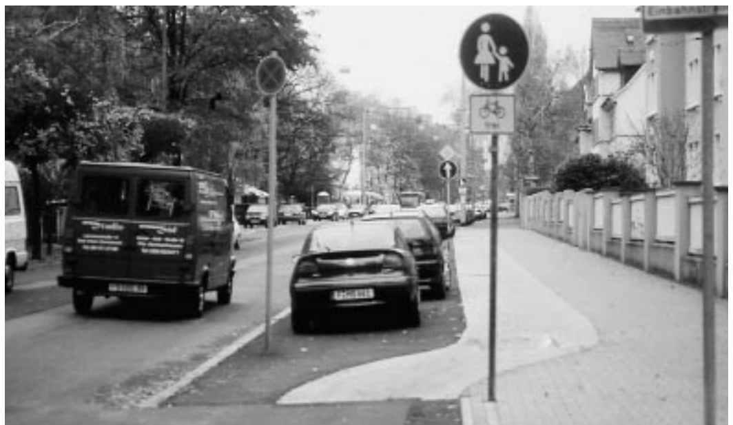
Marbachweg: Glatt asphaltierte Parkstreifen, daneben Radwege mit sattem bekanntem Rüttelpflaster. Die Auffahrten hektisch verschwenkt und ohne Sicherung gegen Falschparker (siehe Seite 4). Foto: (fb)
