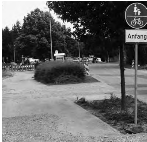
Baustelle als benutzungspflichtiger Radweg in Eppstein-Vockenhausen
