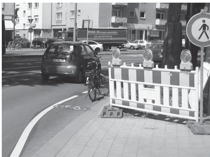
Immerhin hat doch noch mal jemand an Radfahrer gedacht – Baustellenumfahrung an der Hanauer Landstraße
