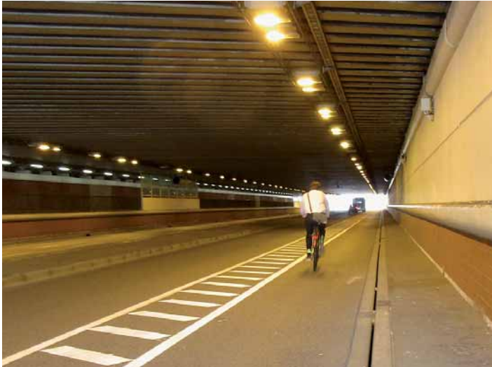
Eine wirklich gravierende Verbesserung im zentralen Bereich: der neue Radstreifen im Hafentunnel. Dafür entfiel eine überflüssige Autofahrspur.
