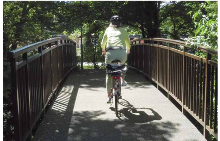
Erneuerte Brücke – jetzt mit rutschsicherem Belag – beim Krifteler Schwimmbad
