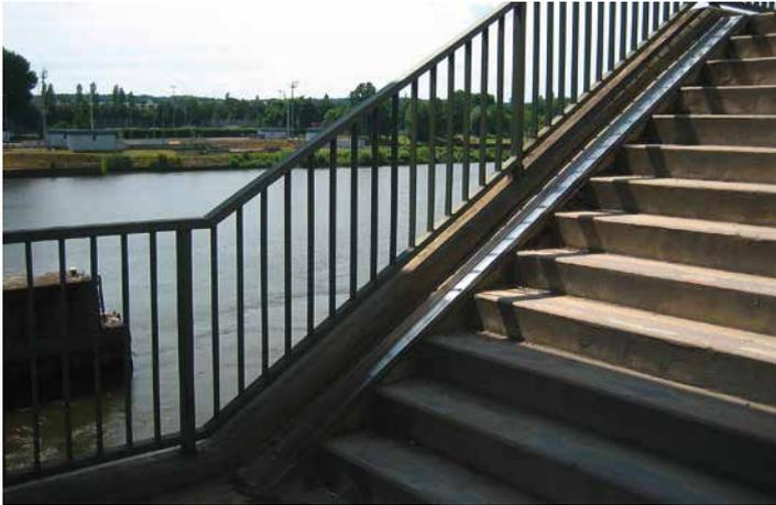
Bei Nässe gefährlich: Schieberinne aus Edelstahl, hier an der Treppe der Staustufe Offenbach am Brückenkopf Franziusstraße. Diese Konstruktionen sollten rückgebaut werden.
