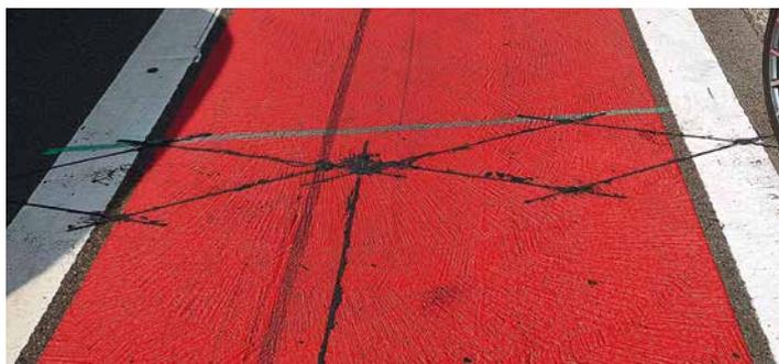
Hier ist das Rautenmuster der in der Asphaltdecke installierten Induktionsschleifen gut erkennbar.
