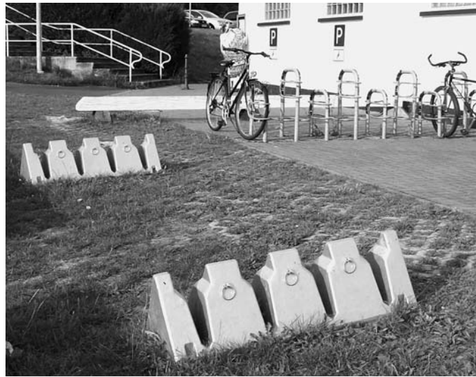
Völlig ungeeignete „Felgenkiller“-Fahrradabstellanlagen vor dem Wehrheimer Schwimmbad.
