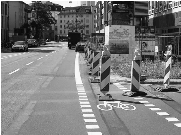
Seit Monaten tote Hose – gesperrter Radfahrstreifen Eschersheimer Landstraße Foto: Fritz Biel
