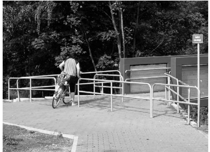
Moderner Festungsbau – neue Niddabrücke an der Marquardstraße in Rödelheim Foto: Ralf Erbskorn
