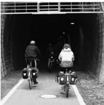
Eingangs des Tunnels auf dem Milseburggradweg, der unter der Milseburg-Erhebung hindurchführt
