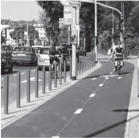
Neuer Zweirichtungsradweg am Friedberger Tor
