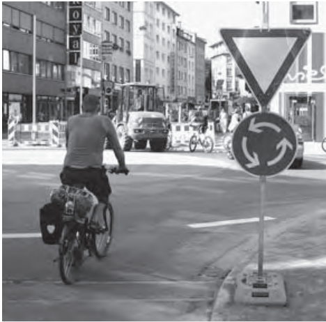
Der neue Kreisverkehr nördlich der Konstablerwache
