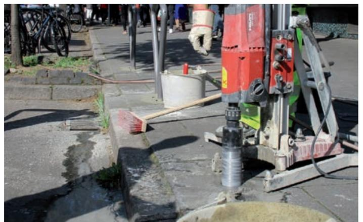
**Preiswert** Das ist eine Fahrradabstellbügellochbohrmaschine. Sie bohrt saubere, runde Löcher, in die Fahrradbügel einbetoniert werden, an die wir später unsere Velos anschließen können. Geht aber nicht für neunzehnfundneunzig. Taugt dafür etwas.
