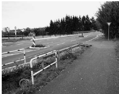
Die neue Querungshilfe entschärft die Situation erheblich.
