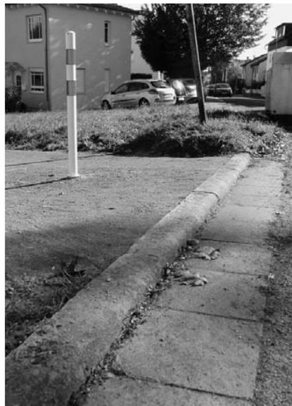
stellt. Bislang wurde ein Trampelpfad über das Feld benutzt, nun gibt es einen richtigen Weg mit wassergebundener Decke. Leider wurde am Pfaffenweg der Bordstein nicht abgesenkt, so dass man über eine Kante fährt, die je nach Richtung auch schräg angefahren werden muss. Der ADFC wird hierauf aufmerksam machen.
