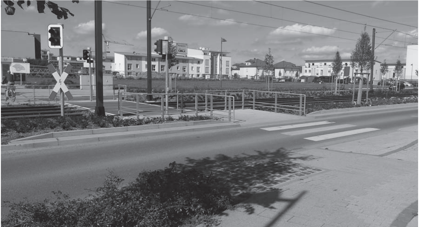
Neu gebaut und doch völlig veraltet – Radverkehrsführung über die U-Bahn am Kreisverkehr Altenhöfer Allee / Riedbergallee
