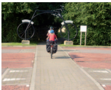
Route kreuzt Parkplatz mit Aufpflasterungen an den Querungen der Radroute durch Autos
