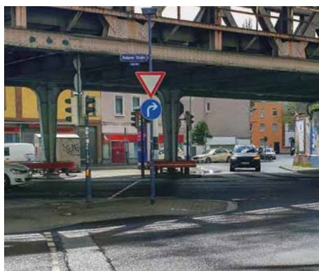
Kreuzungsbereich Hebestraße / Bieberer Straße / Feldstraße / Bahnunterführung: hier wirds eng für den Radverkehr
