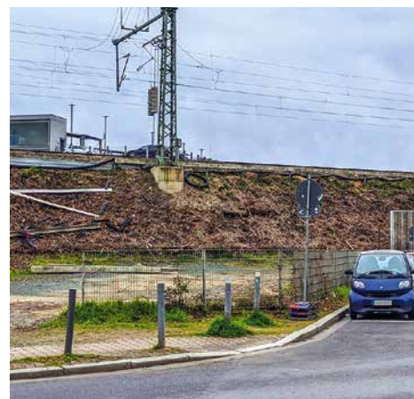
Hier müssen wir durch: Der Tunnel-Durchstich am Homburger Damm ist in Arbeit
