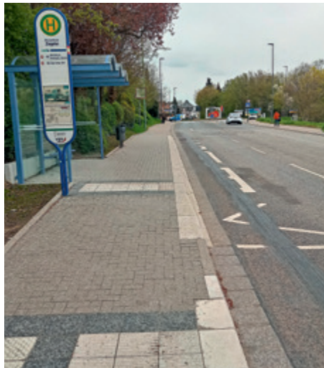
Sturzgefahr gebannt – auf Kosten der Lesbarkeit
