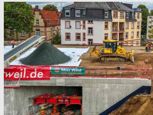
Bevor die Bahngleise wieder verlegt werden können, wird Schotter aufgebracht
