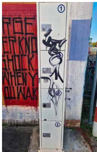
Ladestation am Freibad – der ausgebaute Akku ist im Schrank mit eigenem Ladegerät zu laden
