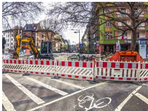
Kein Durchkommen in Bornheim: Baubedingte Vollsperrung der Spessartstraße
