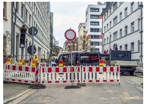
Seit Jahren ist die Ringelstraße in Bornheim immer mal wieder wegen einer Baustelle gesperrt
