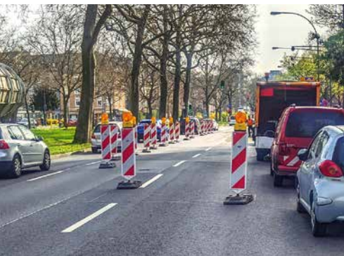
Auf der Nibelungenallee fließt der Verkehr baustellenbedingt klaglos einspurig
