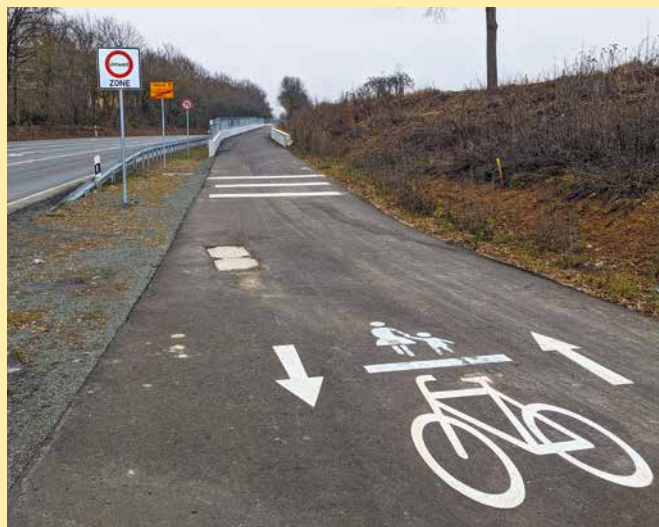
Der wichtige Lückenschluss ist zwar nur wenige Meter lang, aber aufwendig im Bau gewesen.
