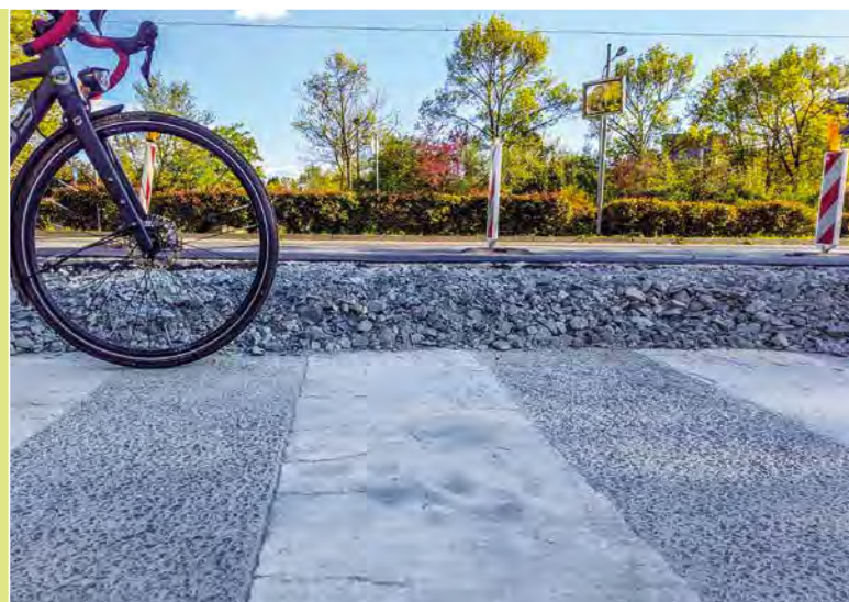
Der Höhenunterschied zwischen dem alten, niedrigen Zebrastreifen und dem neuen, erhöhten Radweg (auf dem Schotterbett) ist beachtlich: Bisher mussten Radfahrende immer über eine Kante in die Senke eintauchen und über eine weitere hohe Kante wieder heraus fahren.
