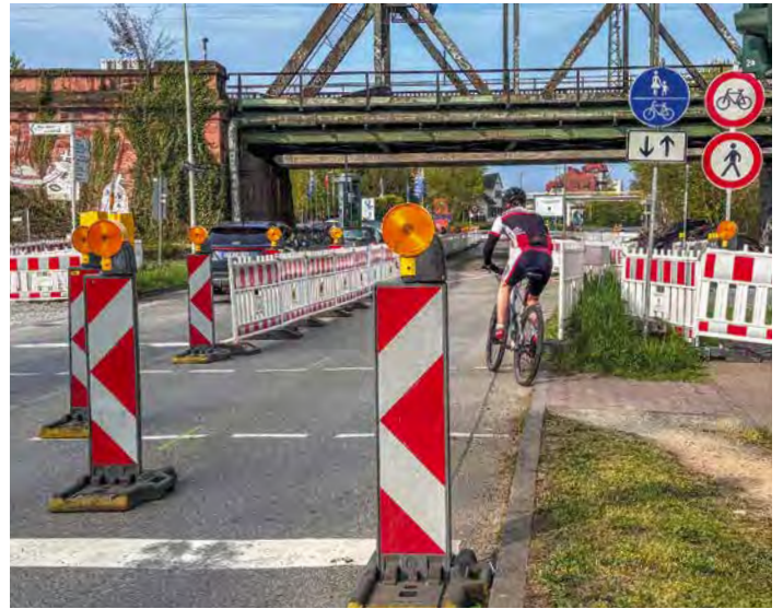
Sichere Führung des Radverkehrs an einer Baustelle: In Niederrad wurde dazu eine Kfz-Fahrspur umgewidmet
