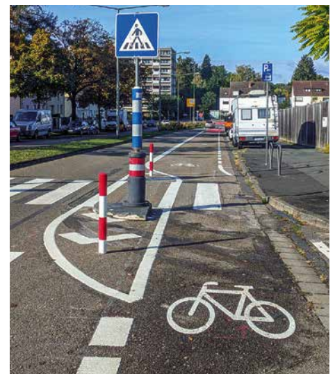
Der Abschnitt „Am Stockborn“ ist für den Radverkehr übersichtlicher und sicherer befahrbar
