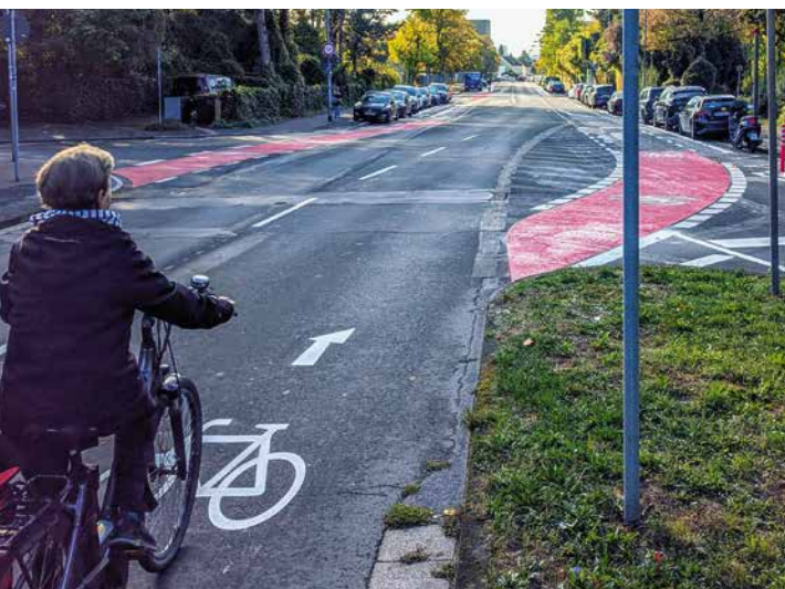
links: Auf dem Praunheimer Weg Richtung Süden wird man hinter der Kreuzung zum Gerhart-Hauptmann-Ring mit neuen Markierungen auf der Fahrbahn geführt. Der ehemalige Hochbord-Radweg wurde zum Parkplatz.
